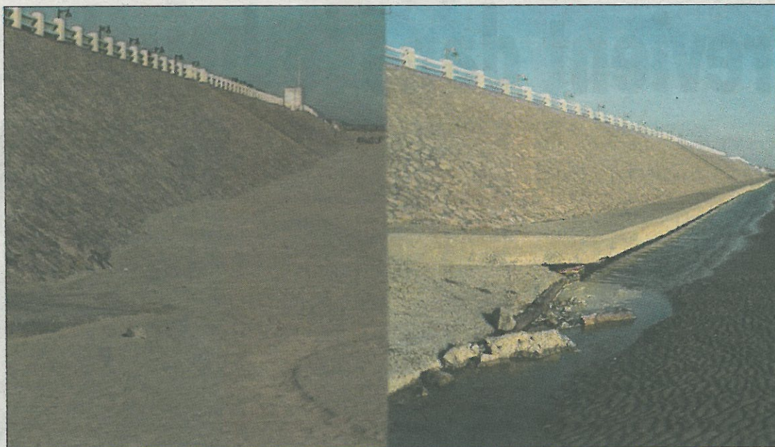
La digue de Quend avant l'installation du système (à gauche) et quelques mois après (à droite). On note un assèchement très net.
